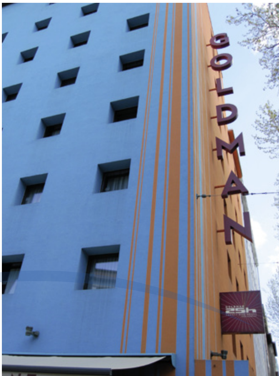
Das Hotel Goldman 25hours in der Hanauer Landstraße. Jedes der 49 Zimmer ist individuell nach den Vorstellungen von 49 Frankfurter Persönlichkeiten gestaltet worden.
