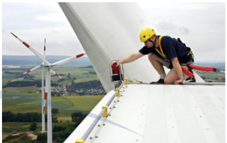
Inspektion der Befeuerung
